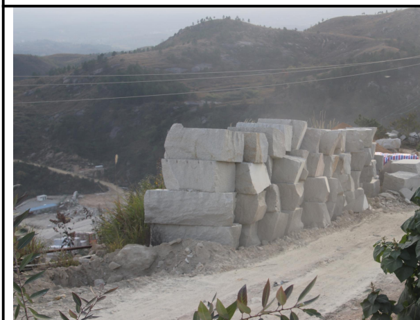
干砌石挡土墙
