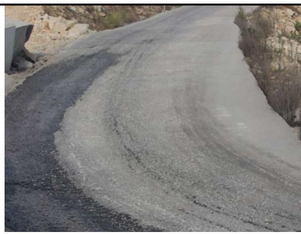
运输道路硬化
