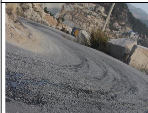
运输道路硬化
