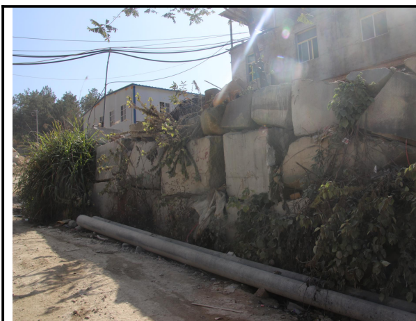
干砌石挡土墙
