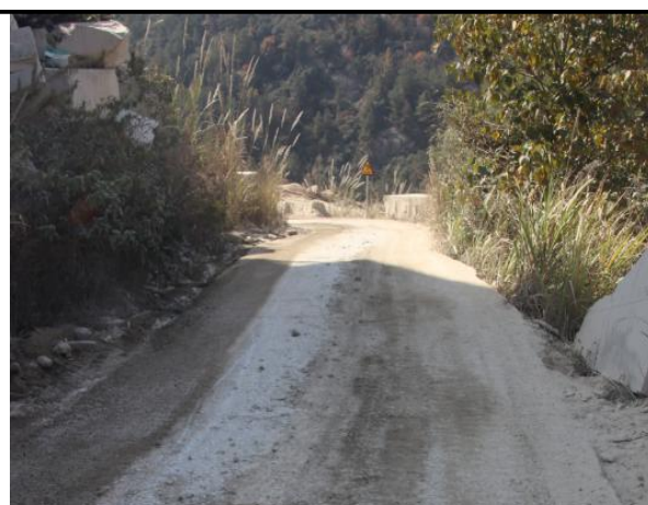
运输道路硬化、排水沟
