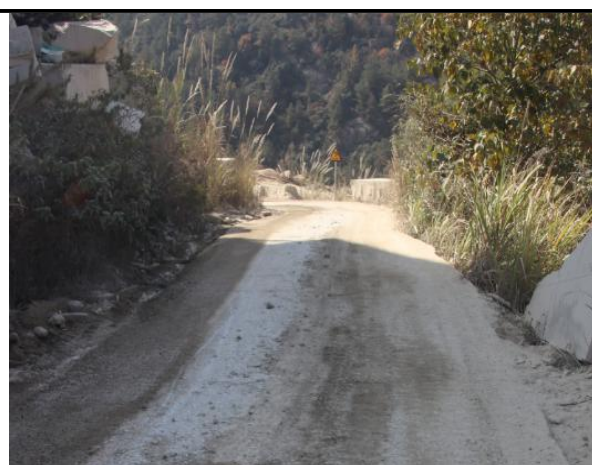
运输道路硬化、排水沟
