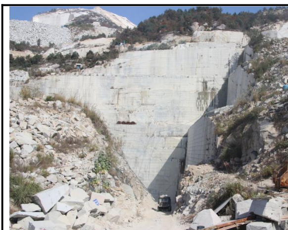
矿山开采区现场
