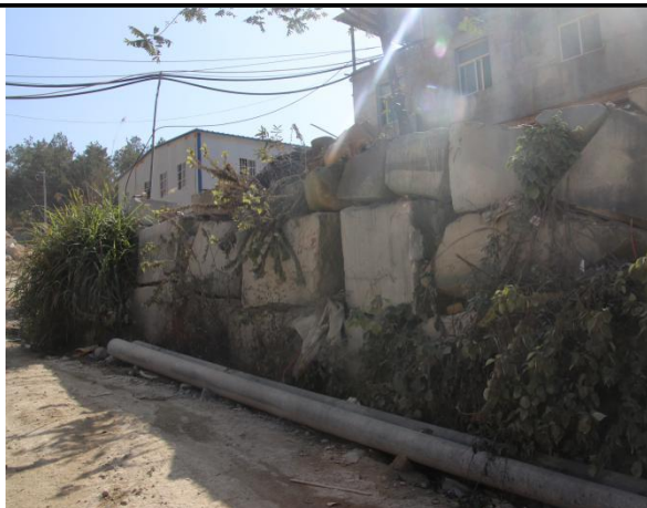
干砌石挡土墙
