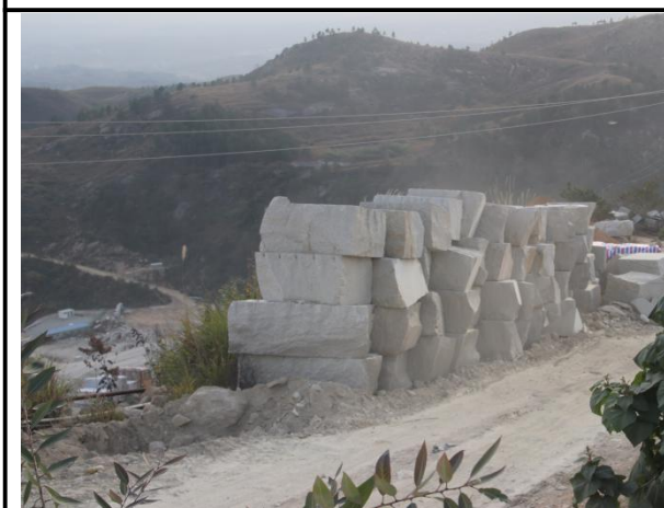
干砌石挡土墙
